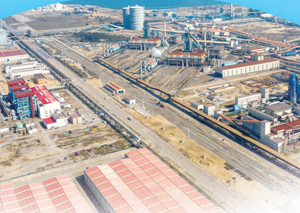
炼铁厂、动力厂区域环境面貌焕然一新
