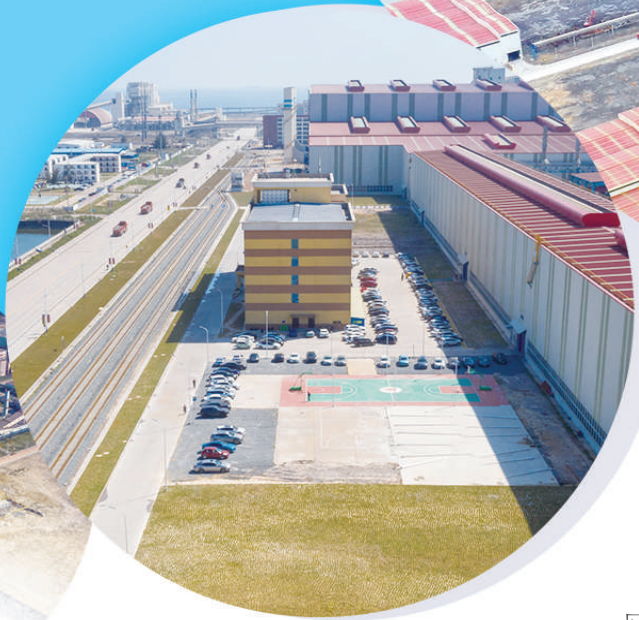
整洁有序的棒线厂办公楼区域
